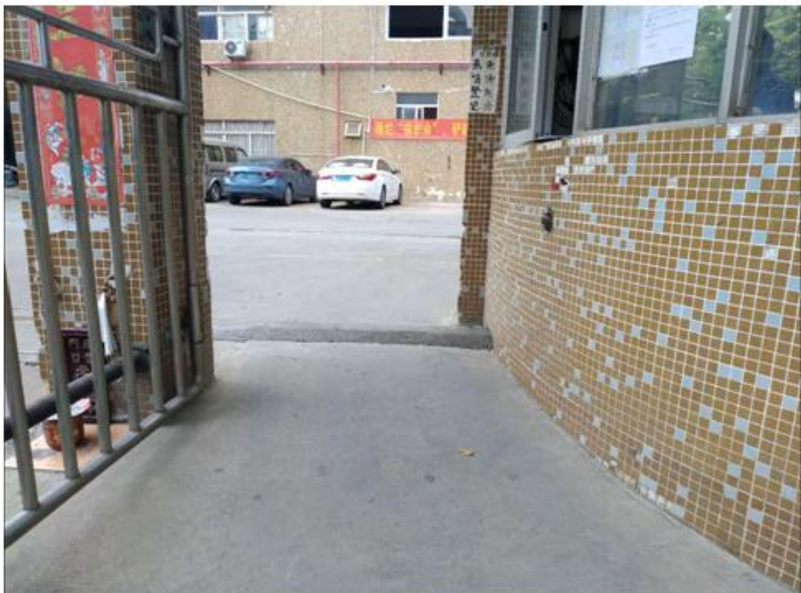
附件二：雨水排口事故废水截止措施整改后照片
