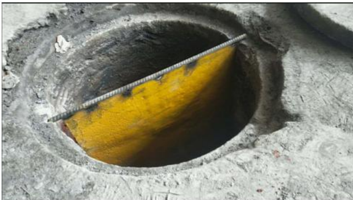
附件二：雨水排口事故废水截止措施整改后照片
